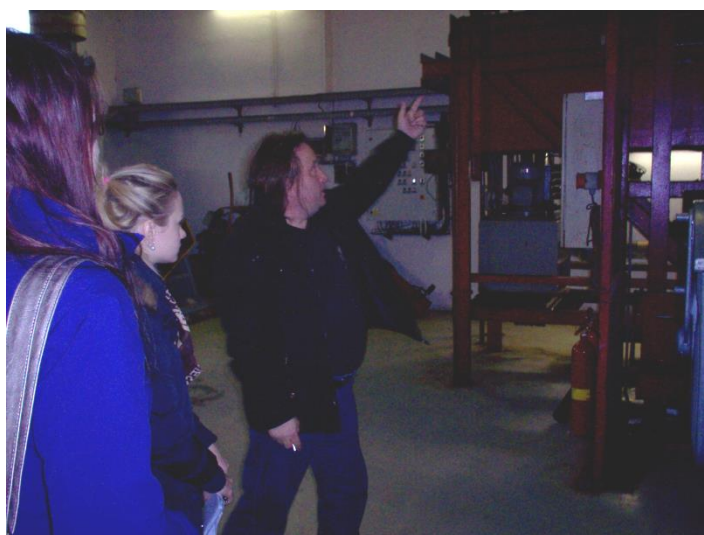
Obr. 5: Pan Slepíčka nám ukazuje, jak pracuje kotel spalovny
